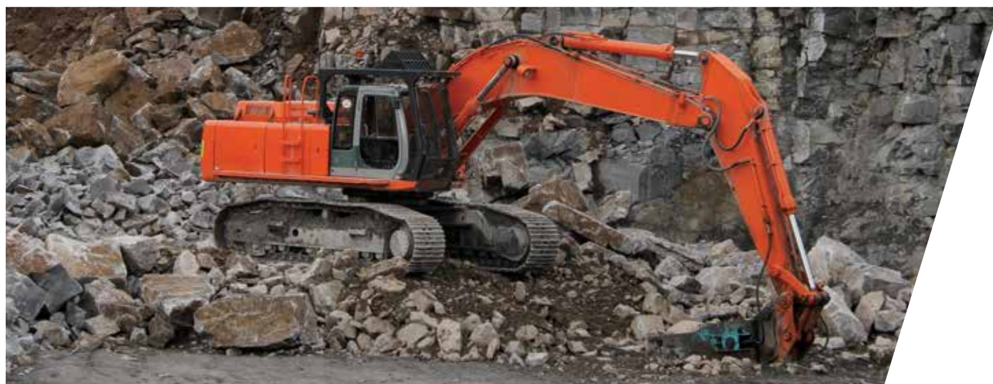
Koparka budowlana z częściami eksploatacyjnymi MTG pracująca w Irlandii.
